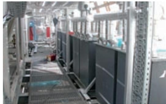
**Figura 4.** Instalación de climatización con baterías de aluminio, con 8 m<sup>3</sup> de PCM.
