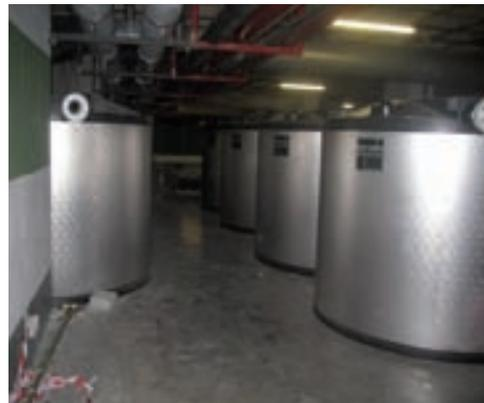
**Figura 5.** Instalación de climatización con tubos de plástico espirales con 168 m<sup>3</sup> de PCM.
