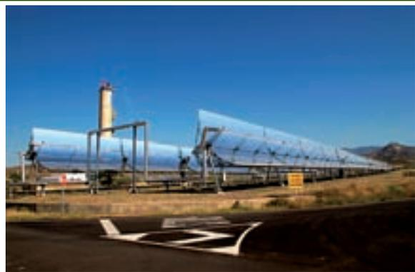
Figura 3. Lazo experimental para generación directa de vapor en la Plataforma Solar de Almería (PSA) [3].
