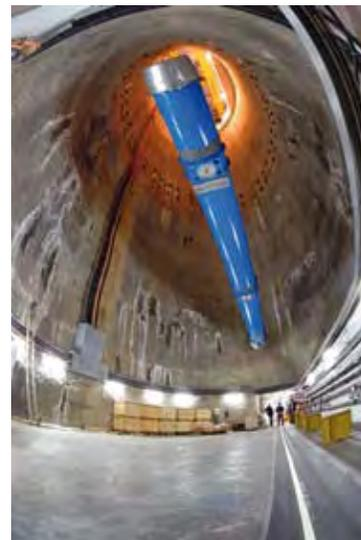
Descenso del último de los 1.232 imanes dipolares superconductores del LHC.
